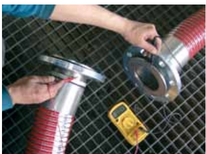
Conductividad eléctrica. Electrical continuity.
