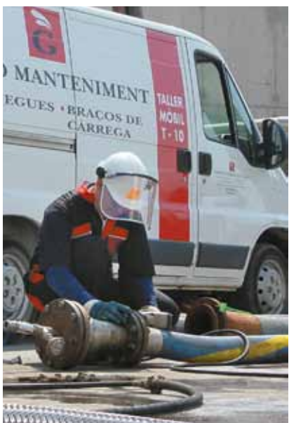
Mantenimiento y reparación. Repairs and maintenance.
